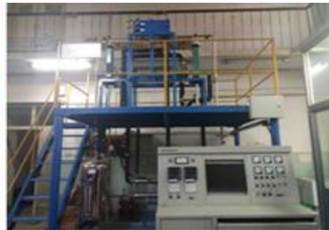
化工智能实训平台
